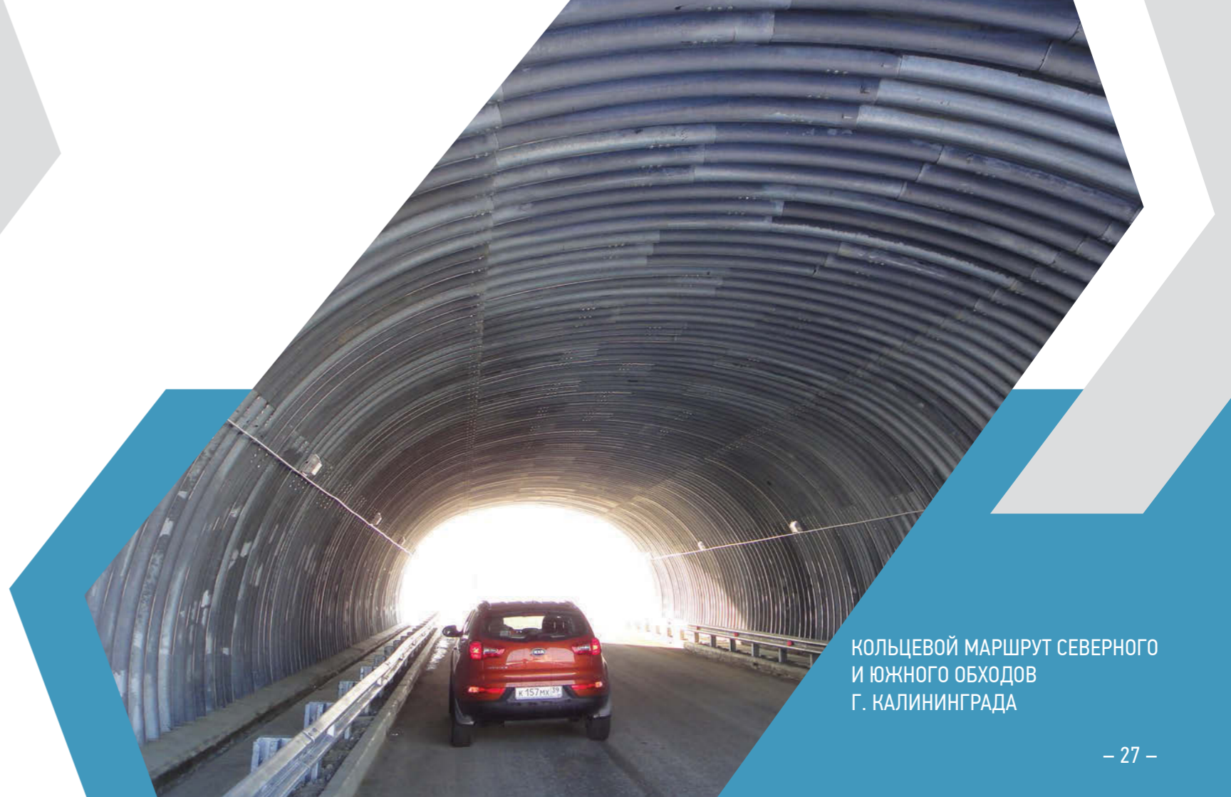
МОНТАЖНЫЕ РАБОТЫ ПО СБОРКЕ МГК
