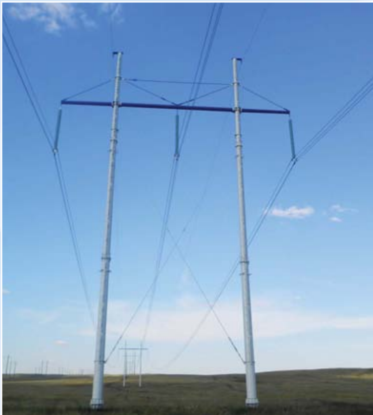
Строительство ВЛ 500кВ «ПС Красноармейская – ПС Газовая» Оренбургская, Самарская обл. Применены адаптированные к региональным условиям опоры с декоративным покрытием.
