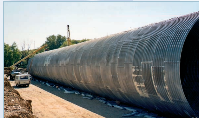
Строительство МГК круглого сечения, диаметром 6 м, длиной 100 м (река Кура, Ставропольский край)
