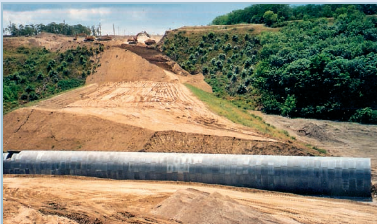
Строительство МГК круглого сечения, диаметром 6 м, длиной 100 м (река Кура, Ставропольский край)
