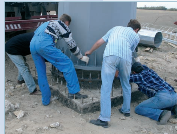
Монтаж телекоммуникационной башни высотой 30 м
