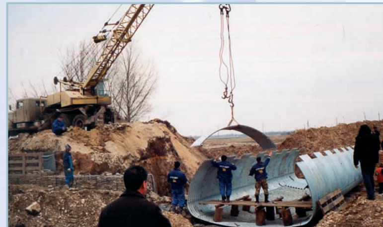
Строительство МГК круглого сечения, диаметром 6 м, длиной 100 м (река Кура, Ставропольский край)
