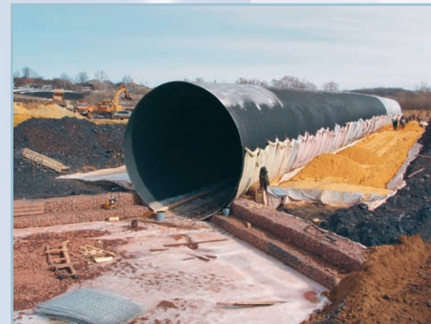
Строительство МГК круглого сечения диаметром 6 м, длиной 100 м (ж/д Белгородская обл.)
