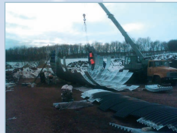
Строительство МГК круглого сечения диаметром 6 м, длиной 100 м (ж/д Белгородская обл.)
