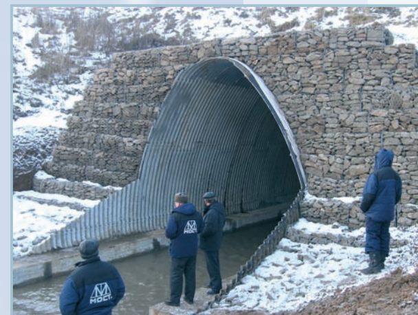
Ремонт арочного ж/б моста методом «гильзования» (Горьковская ж/д)
