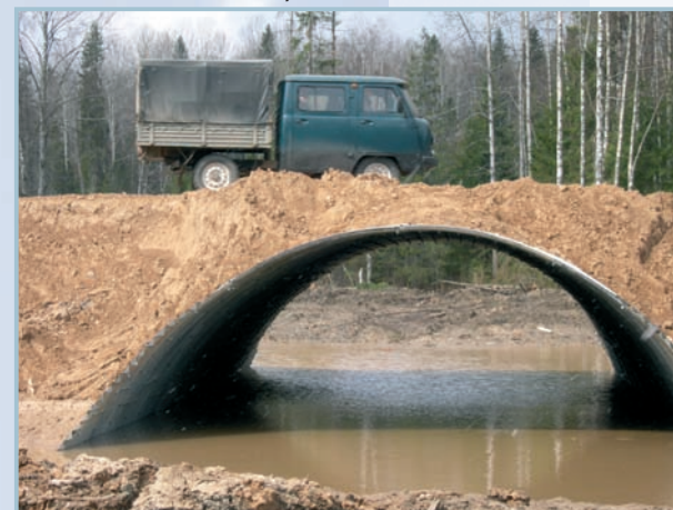
Строительство арочного моста (Строительство нефтепровода. Вологодская обл.)
