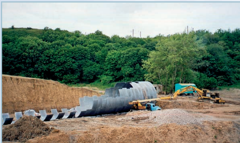
Строительство МГК круглого сечения, диаметром 6 м, длиной 100 м (река Кура, Ставропольский край)
