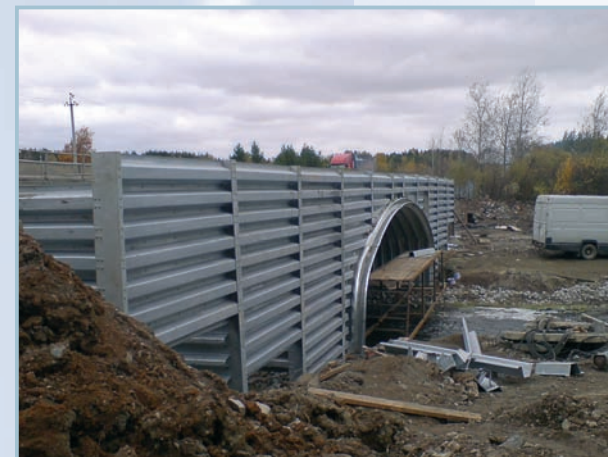
Замена ж/б моста на «мостолист» арочного сечения с применением подпорных стенок
