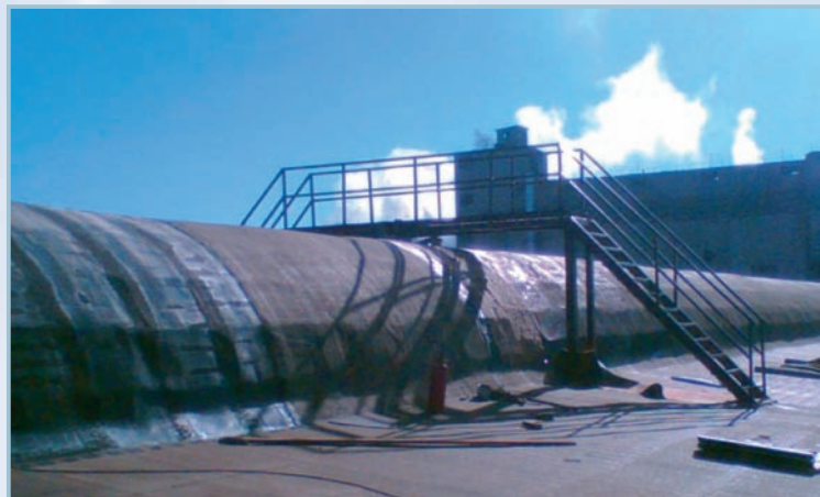
Вентиляционная шахта на крыше ТЦ (г. Нижний Новгород)
