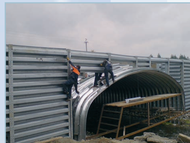
Замена ж/б моста на «мостолист» арочного сечения с применением подпорных стенок
