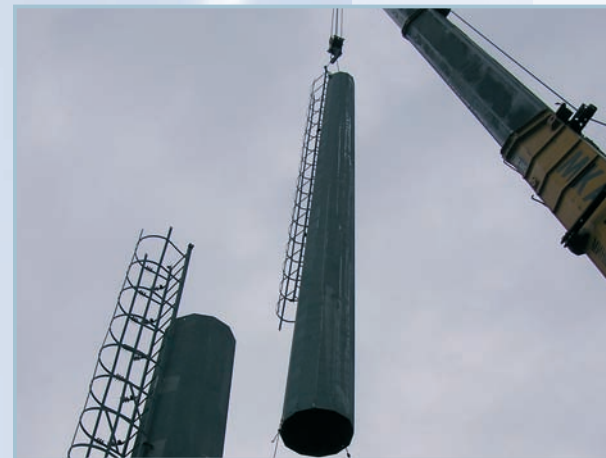
Монтаж телекоммуникационной башни высотой 30 м
