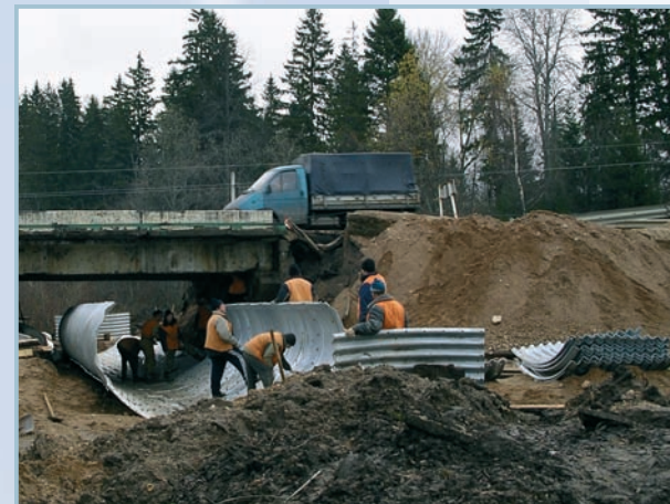
Замена моста на МГК эллиптического сечения
