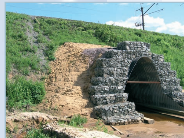
Ремонт арочного ж/б моста методом «гильзования» (Горьковская ж/д)
