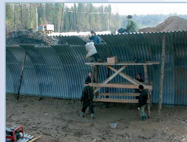
Строительство арочного моста (Строительство нефтепровода. Вологодская обл.)
