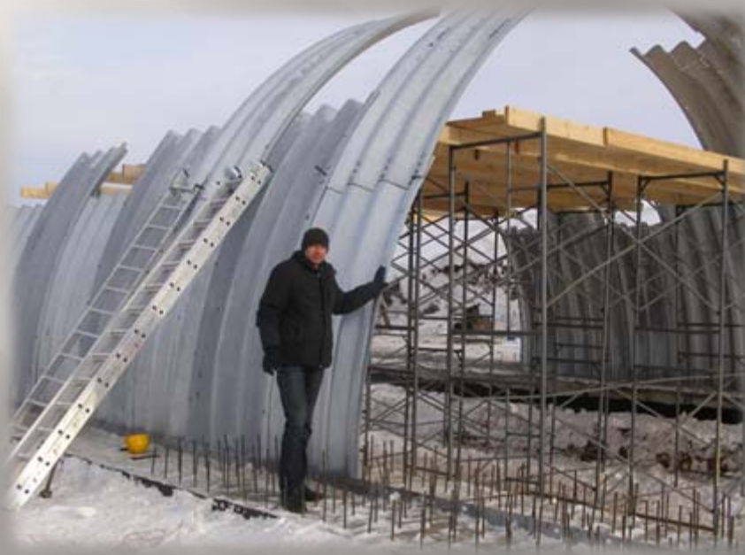
Путепровод на автомагистрали в Татарстане
