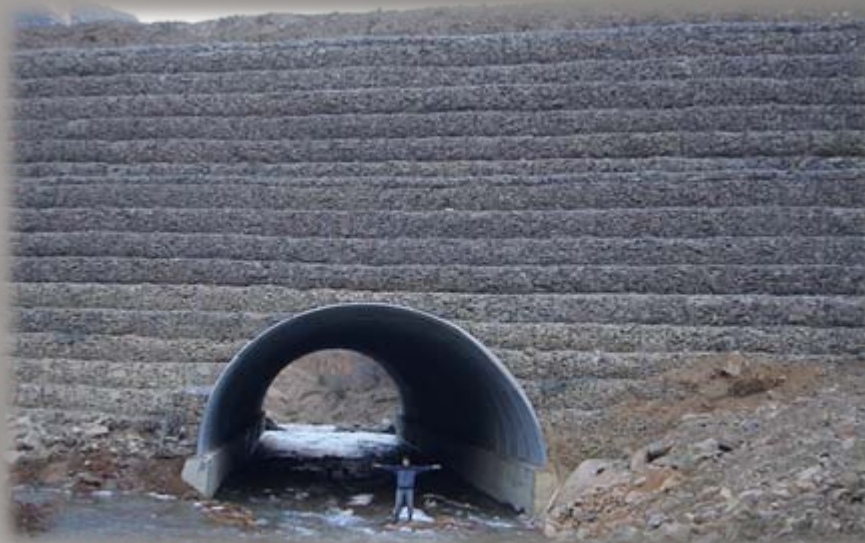
р. Харбас. Кабардино-Балкария. Арка пролетом 10м
