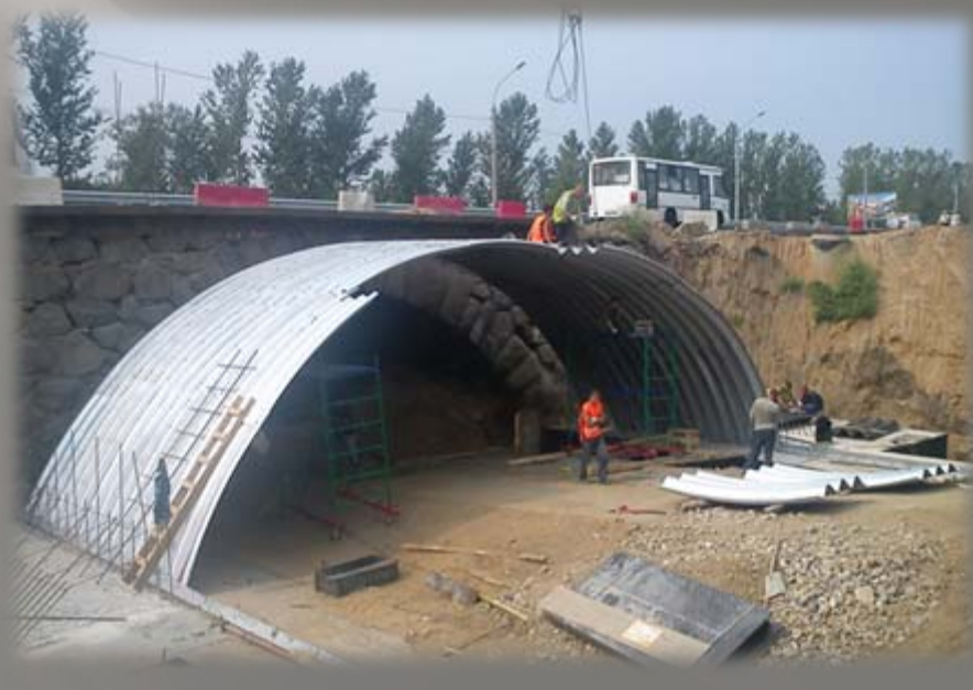
Реконструкция путепровода в Ярославле
