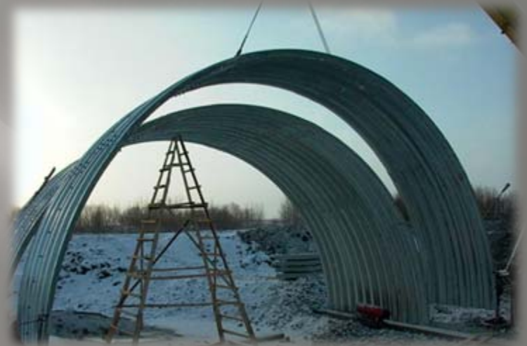
Последовательная кольцевая сборка.
