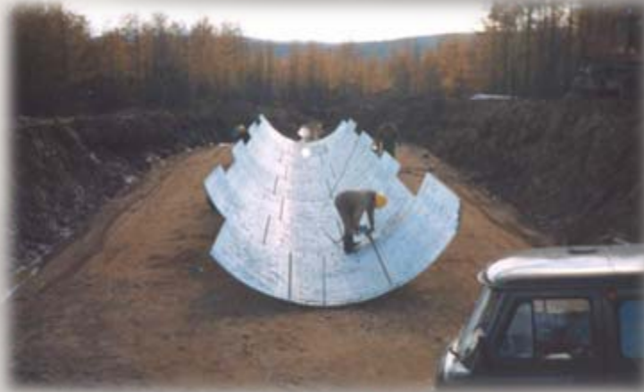
Последовательная листовая сборка.
