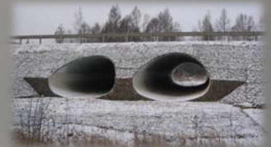
Срез по откосу оголовком из габионов
