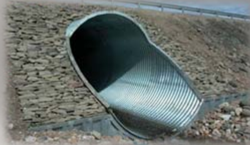
Срез по откосу с углом окаймления
