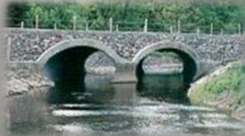
Железобетонный воротниковый оголовок
