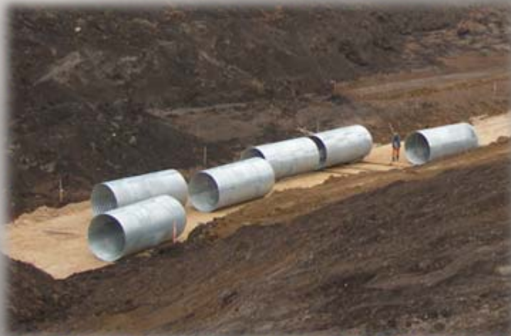
Монтаж конструкции 100% готовности
