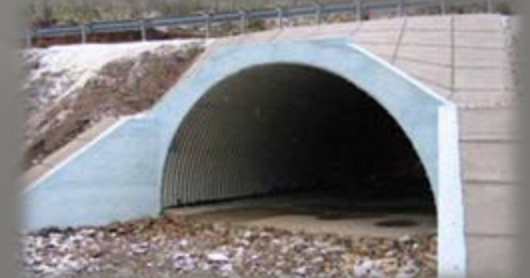
Раструбный железобетонный оголовок
