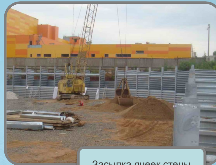
Засыпка ячеек стены
