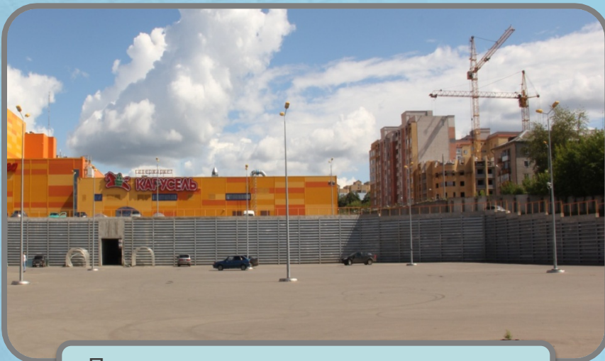
Подпорная стена для парковки торгового комплекса г. Киров
