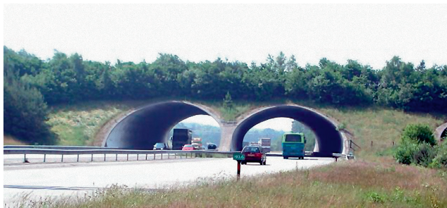
Пример компоновки моста или биоперехода мостового типа
