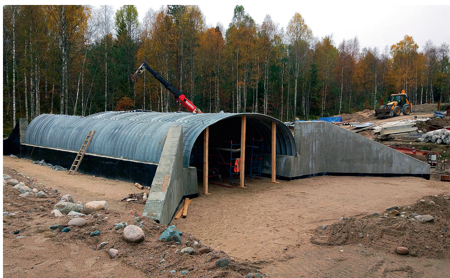
Строительство автомобильной дороги А-121 «Сортавала» Санкт-Петербург – Сортавала – автомобильная дорога Р-21 «Кола» на участке км 424 – км 445, Республика Карелия. Скотопрогон на ПК59 (д. Щеккила)
