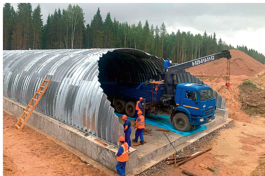
Биопереход трубного типа арочного очертания с фундаментом
