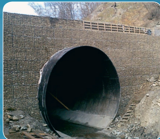
МГК круглого сечения, диаметр 8,25 м, Южная Осетия
