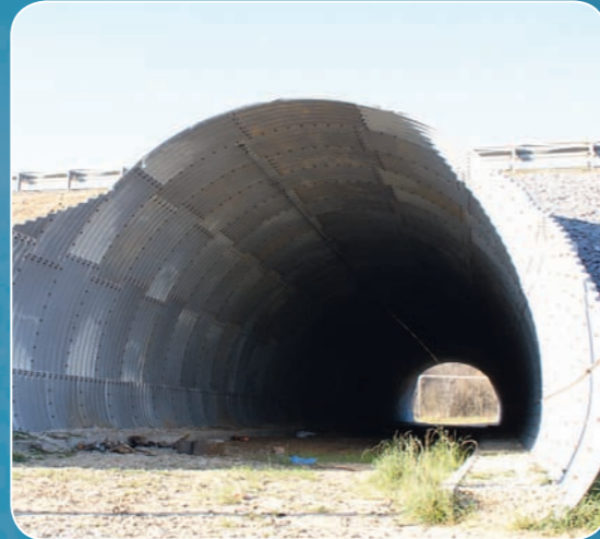
Замена моста на МГК полицентрического сечения, Московская область
