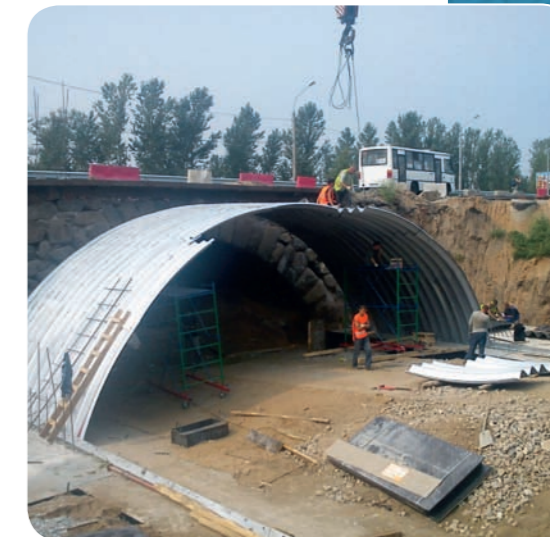
Арка из «супергофра» 14 x 5 м, г. Ярославль
