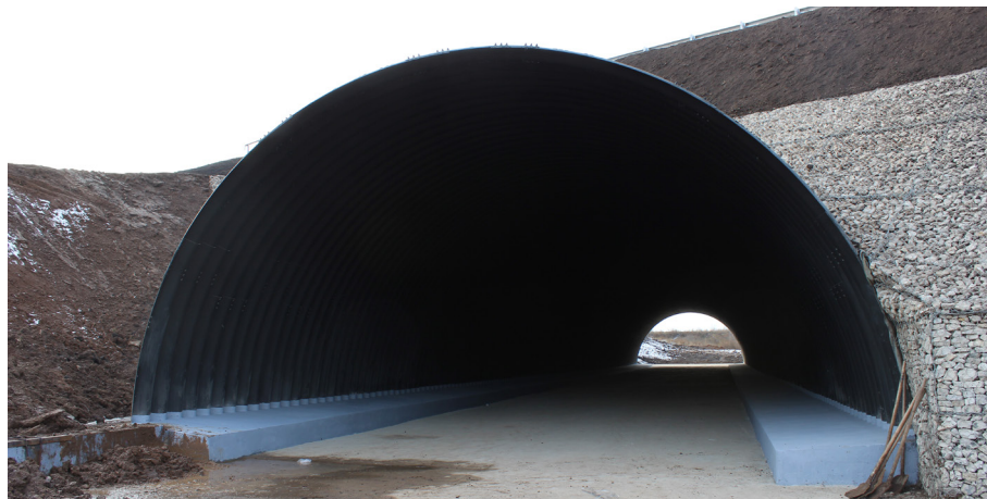
Реконструкция водопропускной трубы на км 105+862 автомобильной дороги Р-240 Уфа-Оренбург, республика Баш-кортостан
