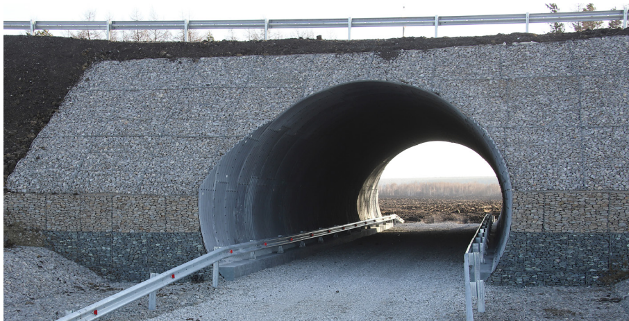
Автомобильная дорога М-5 «Урал» на участке км 1790+358-1799+280, Челябинская область, сооружение для прогона скота на ПК 52+20.00
