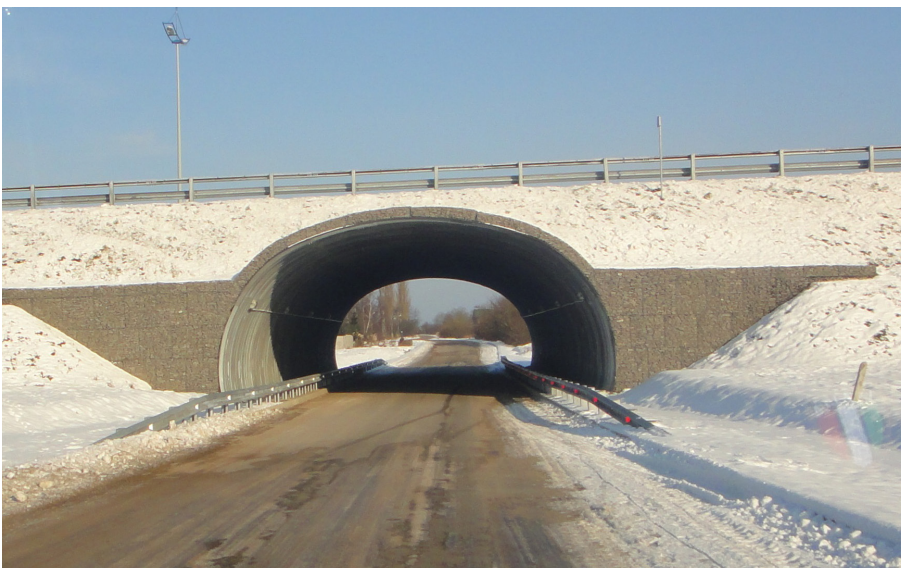
Фото 2. Сооружение из МГК с порталным оголовком без откосных крыльев на половину высоты. Вариант 2
