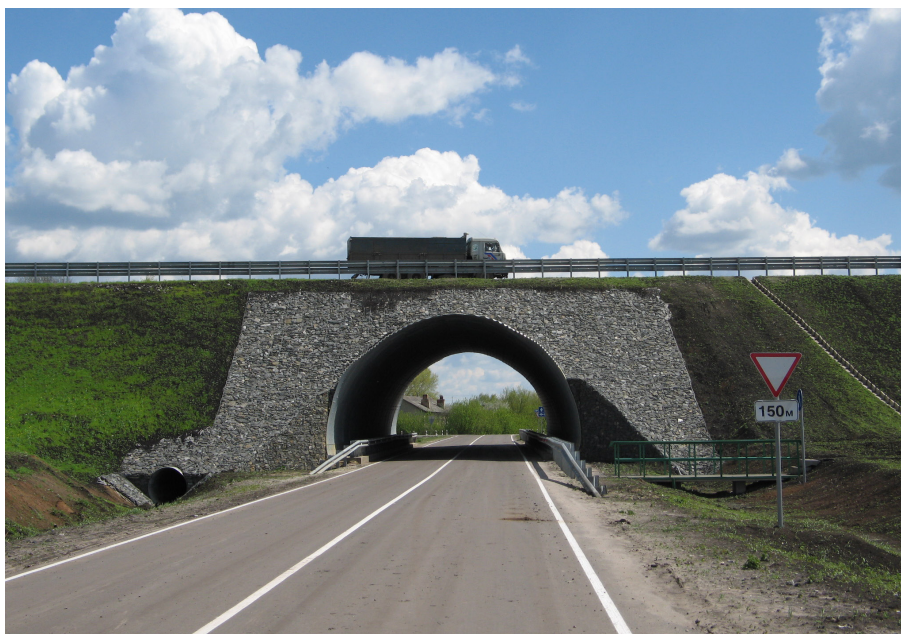
Фото 3. Сооружение со срезанным по откосу оголовком. Вариант 3
