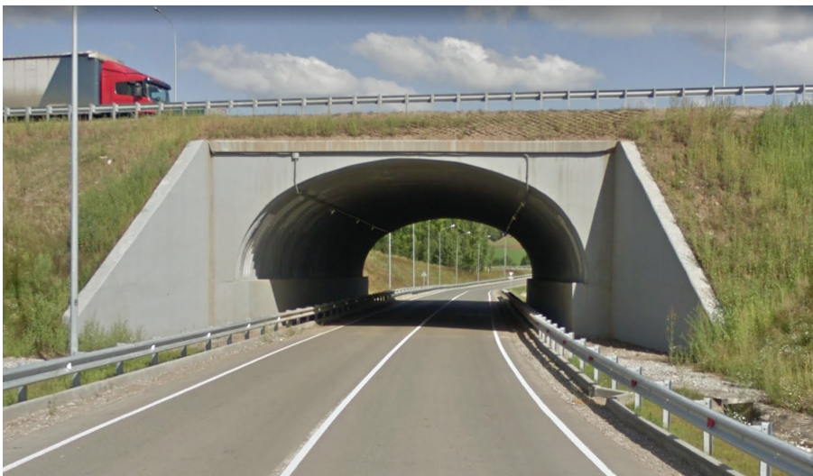
Фото 1. Сооружение из МГК с порталными оголовками и откосными крыльями. Вариант 1
